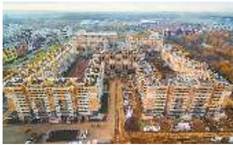
ЖК «Новое Янино», Ленинградская область ГК «ЦДС»
